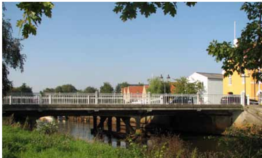
Varde Bro er i sin nuværende skikkelse, en betonkonstruktion fra 1908.
