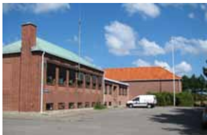
Hovedbygningen til Blåvand Radio med senere tilbygning i baggrunden. Radioen er et af de væsentligste elementer i "sikkerhed til søs"-koncentrationen ved Blåvandshuk.
