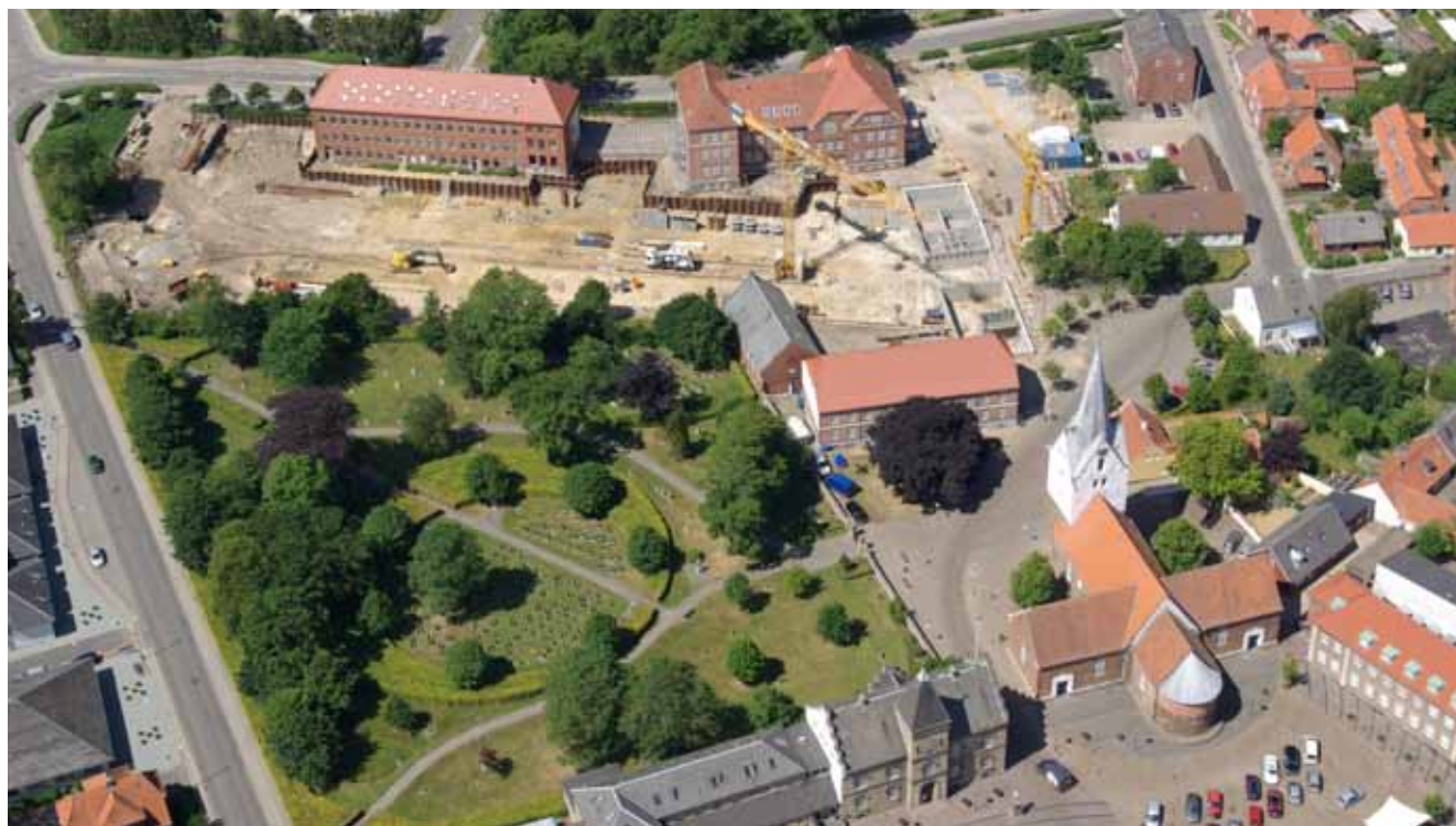
Sct. Jacobi skole under forvandling. Der arbejdes på parkeringskælder og bygges nye huse mod nord. Bygning A er bygningen lige vest for Sct. Jacobi Kirke, bag blodbøgen, og bygning G2 er bygningen med skifertag, der ligger vinkelret på bygning A. Luftfoto taget den 25. juni 2008 af Lene B. Frandsen.
